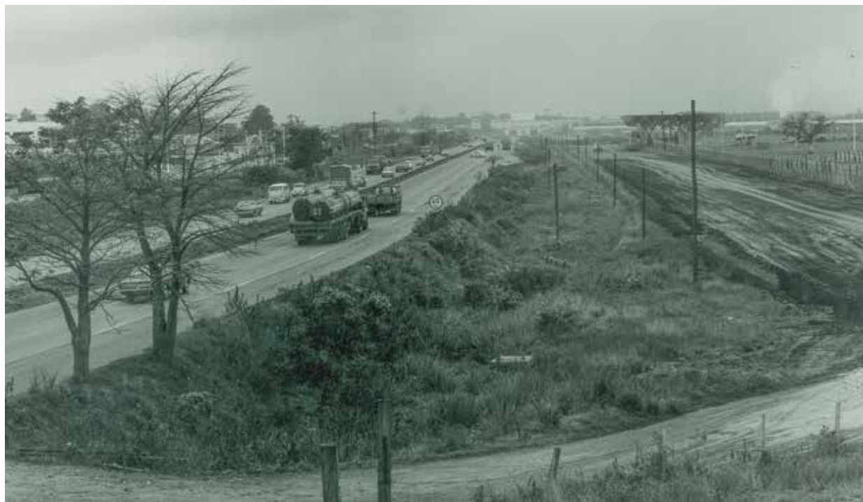
Vista da BR-116, no sentido Interior-Capital. À esquerda, o acesso direto do pórtico de Esteio à estrada. Do lado direito, as obras para a construção da Avenida Independência, em frente ao Parque de Exposições Assis Brasil
